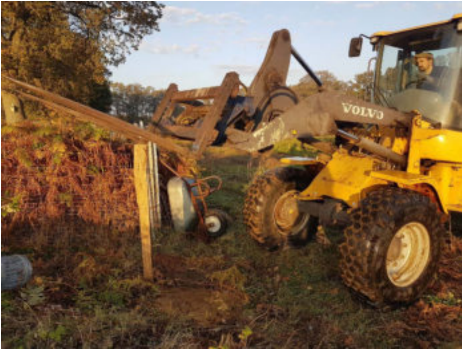
ABBILDUNG 68: RAMMEN VON ECKPFOSTEN
